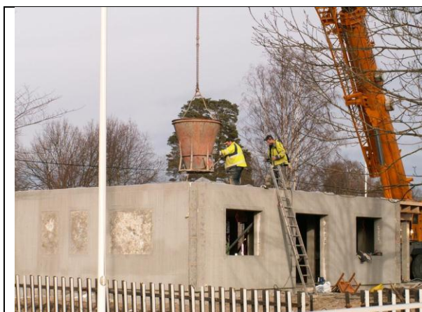
Figur 1 – Produktion av det betonghus som användes för fullskaleförsöken.
